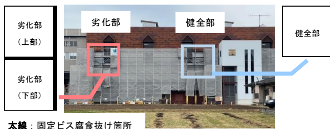
図1 A 駅 測定箇所および劣化箇所
